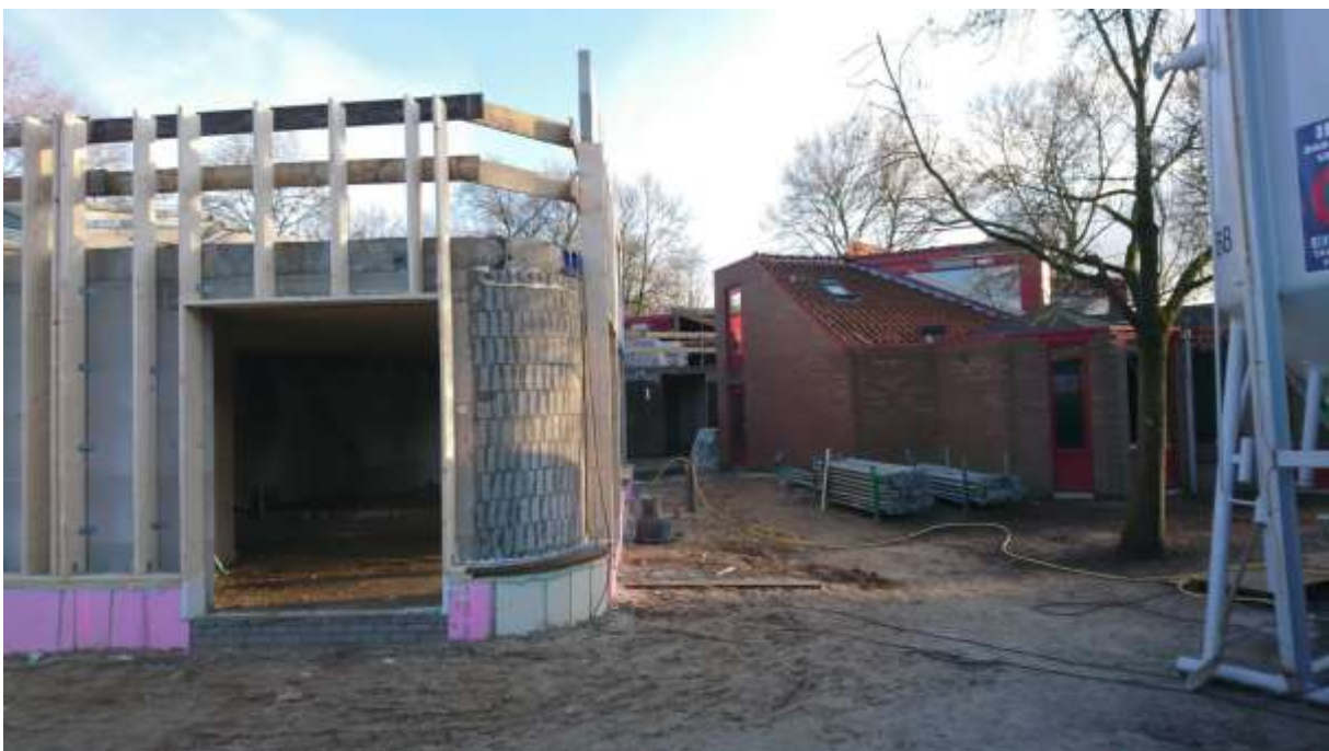
In het midden van de foto zie je de nieuwe hoofdingang van het kindcentrum. Het lokaal rechts op de foto (waar eerst MB1 zat) wordt de ruimte voor handvaardigheid en BSO. Links is de babyruimte zichtbaar.
