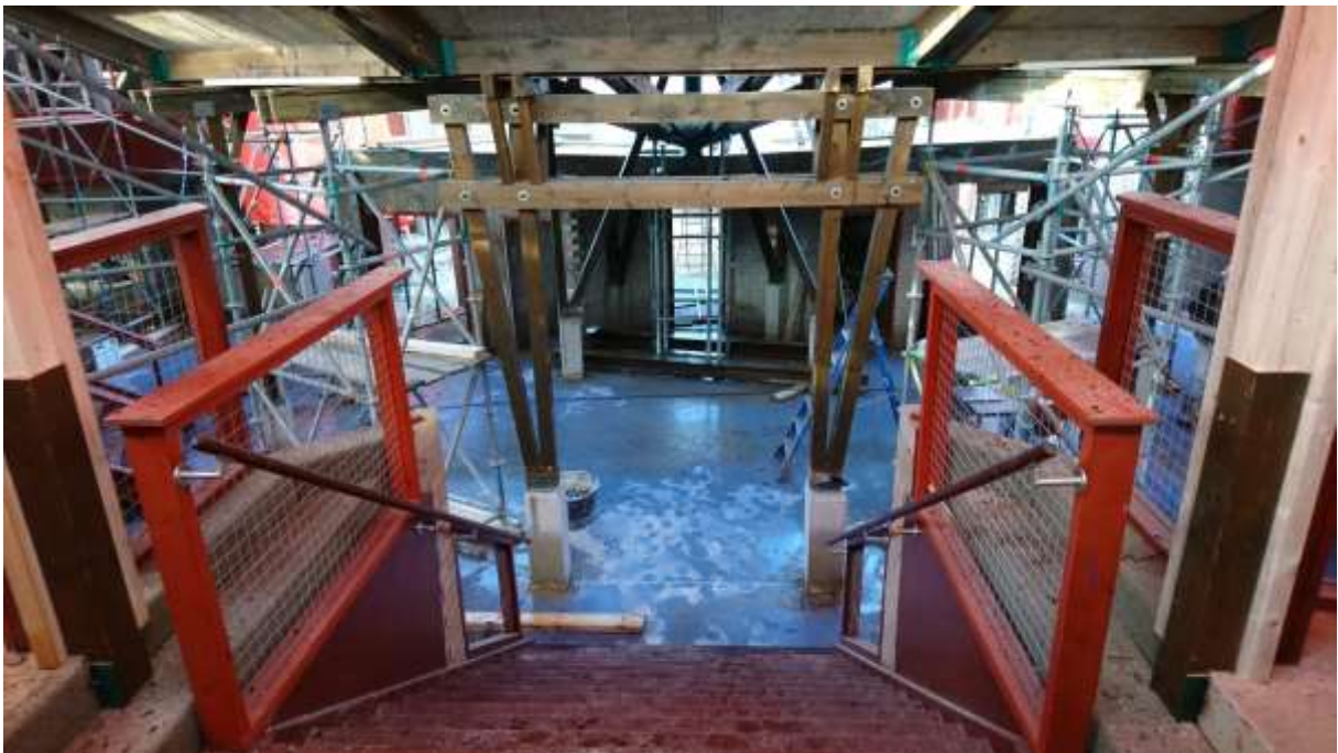
Uitzicht vanaf de omloop naar de hal (en als je nu vanaf de omloop naar het podium kijkt heb je geen last van de balken!)
